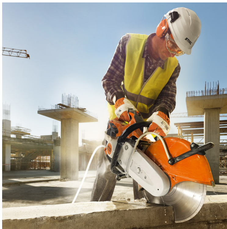
(تصویر ۴-۷): نحوه استفاده از اره بتن بر
